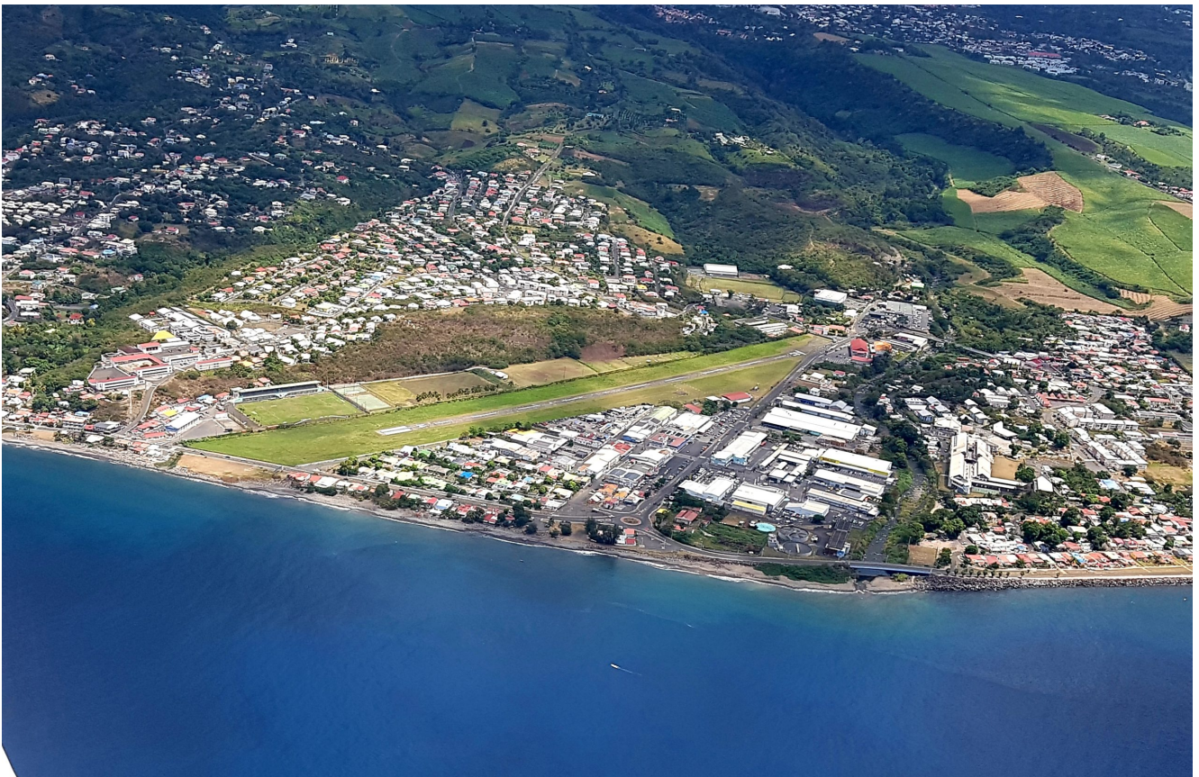
Vue aérienne Aéroport de Baillif
